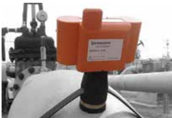
Figura 5 – Sensor ultrassônico Permasense da marca Emerson.
